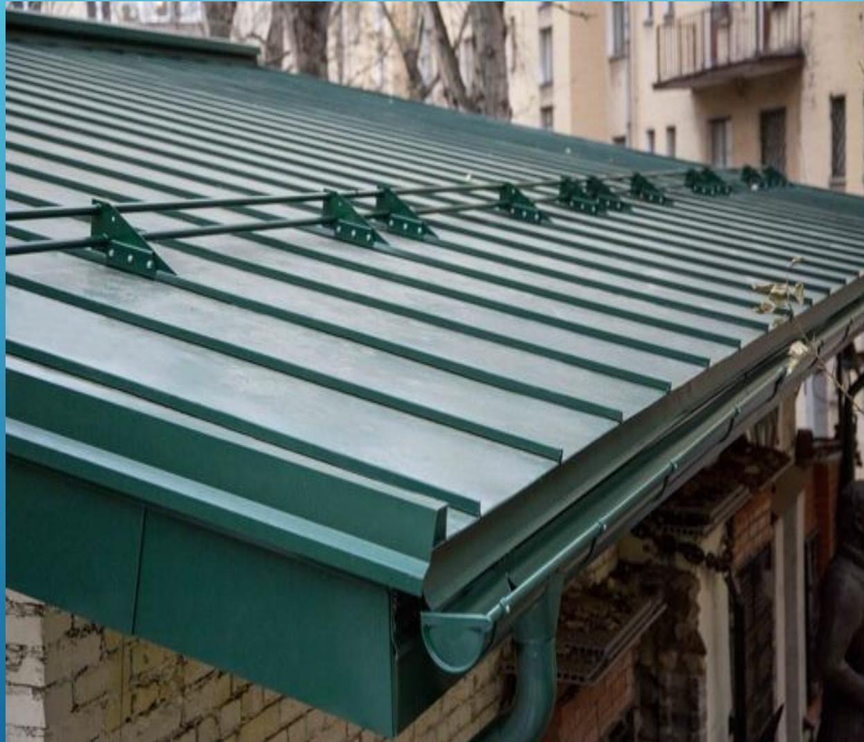
Ja metāla jumta segumu pabalējis vai parādījušās korozijas pazīmes, to iespējams atjaunot, pārkrāsojot. Iegādājoties metāla jumta segumu, jāpievērš uzmanība seguma pārklājumam un metāla biezumam, jo biezāks būs metāls un vairākas aizsardzības slāņu kārtas, jo ilgāks būs tā kalpošanas laiks.
